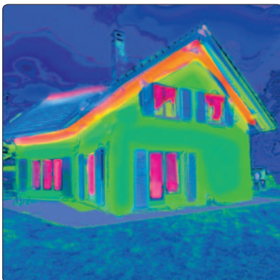
Eine Wärmebildkamera entlarvt veraltete und undichte Fenster.
